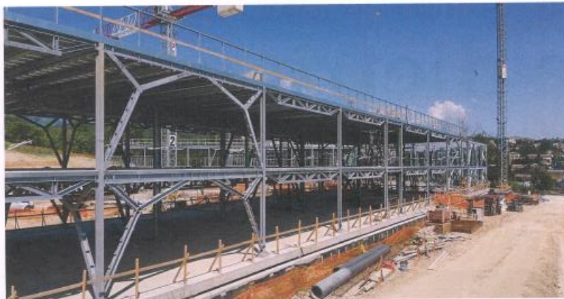
I sistemi di controventamento bidirezionali in profili di acciaio per la tenuta alle azioni orizzontali delle strutture
