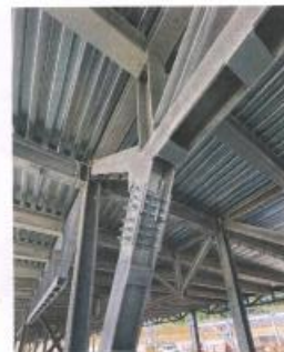
I sistemi di controventamento bidirezionali in profili di acciaio per la tenuta alle azioni orizzontali delle strutture
