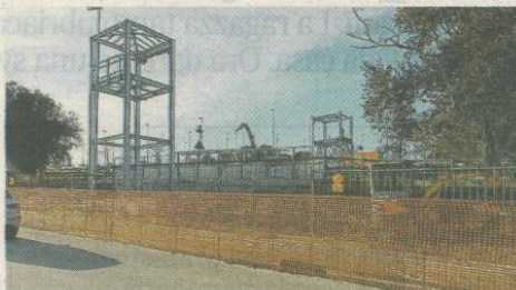
Il ponte pedonale in via di realizzazione
