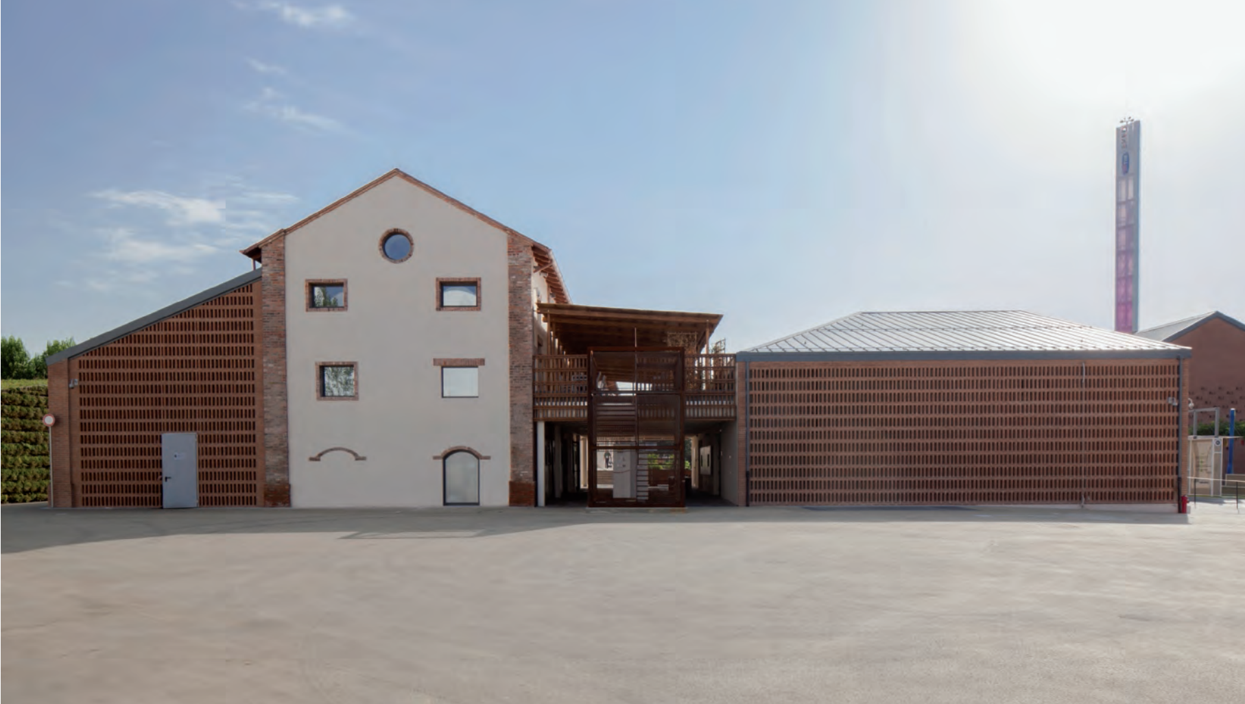
Fronte ovest ex-Granaio.
