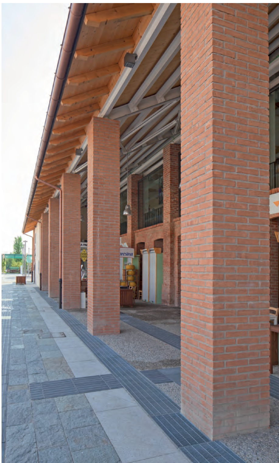
Pilastri del porticato ex-Stalla.
