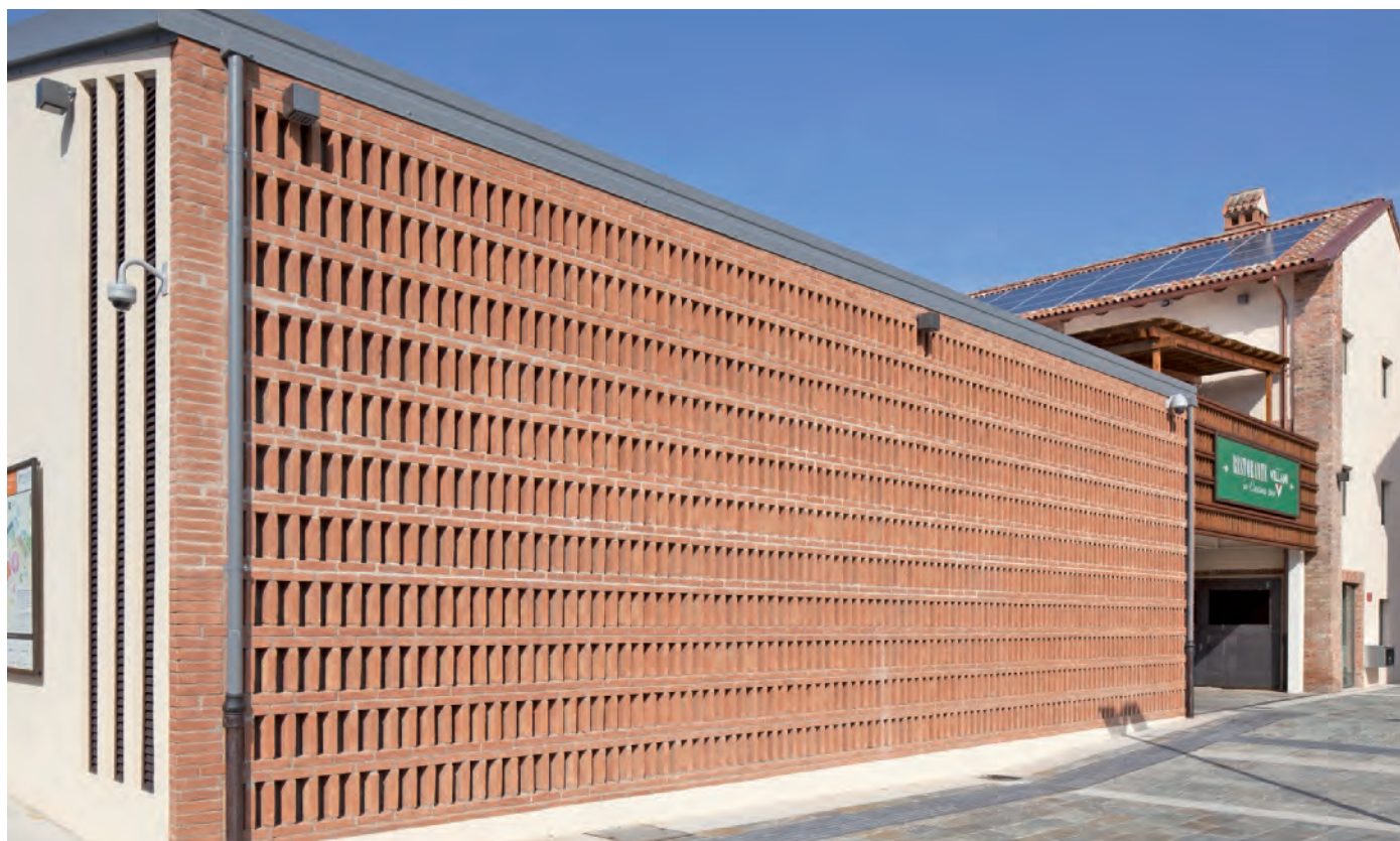
Fronte est ex-Granaio.
